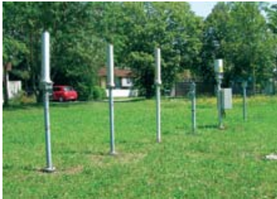
Foto 1. Sonde pentru monitoringul radiologic continuu
