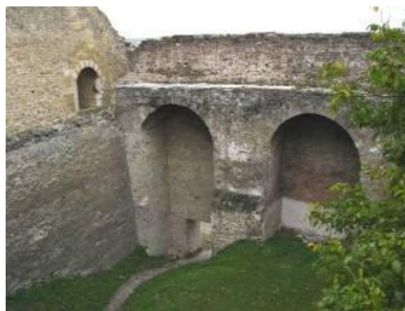
11. Vestigiile părților inferioare a pilonilor podului pentru acces în cetate, vedere din interiorul cetății. Foto T. Nesterov.
