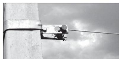
Рис. 12. Механизмы стяжки – замки Grippe (a), другие приспособле-
