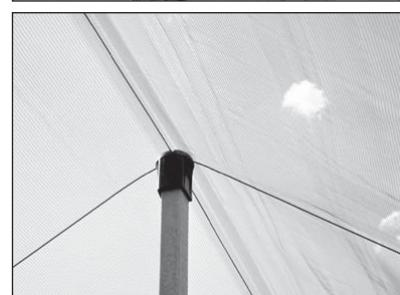
**Fig. 6. Fixarea cablu-funiei în carcasa cu creste**
