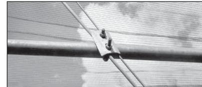
**Рис. 8. Крепление кабеля-троса посредством зажимов**
