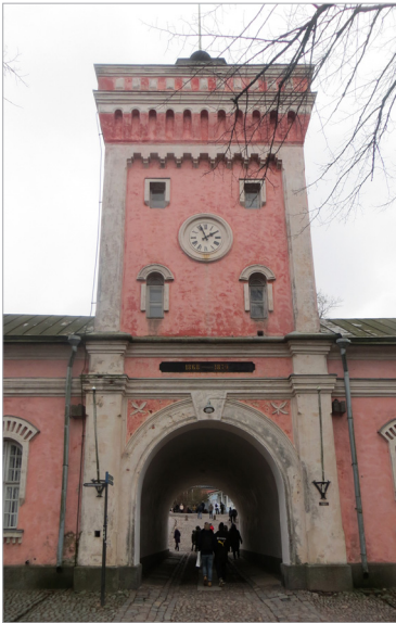
O pasarelă edificată în anii 1868–1871. Foto: IVX, 26 decembrie 2019
