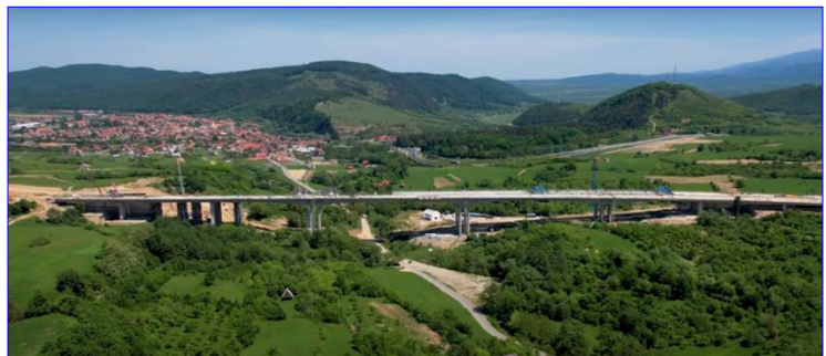
Viaductul de peste Valea Tălmăcelului (autostrada Sibiu – Boița). Structură 3D, beton armat, lungime 650 m, înălțimea maximă 30 m, Foto: Răducu P Drum [27]
