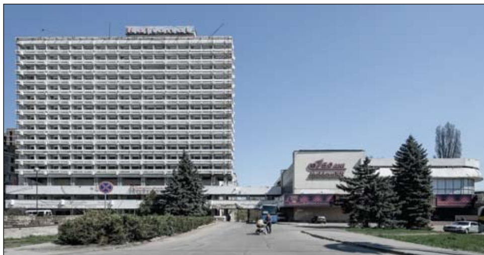
Fig. 4. Fațada principală a Hotelului Național (BACU:2014) 4
