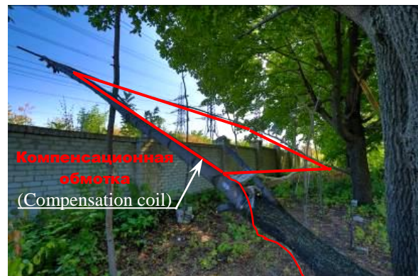
Рис. 5. Компенсационная обмотка системы активного экранирования магнитного поля. 5
