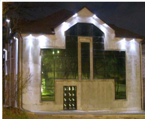
a) Imaginea exterioară, oficiu: 2 etaje și mansardă, consumul interior/exterior - 50W
