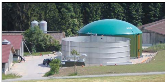
Figura 2. Vederea de ansamblu a unei stații de producere a biogazului, (Firma germană „Luthe GmbH Biogasanlagen”)
