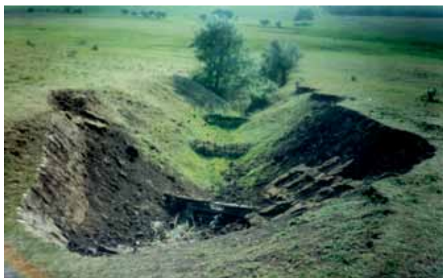
Figura 7. Aspectele ravenei consolidate (inițial și după 13 ani)
