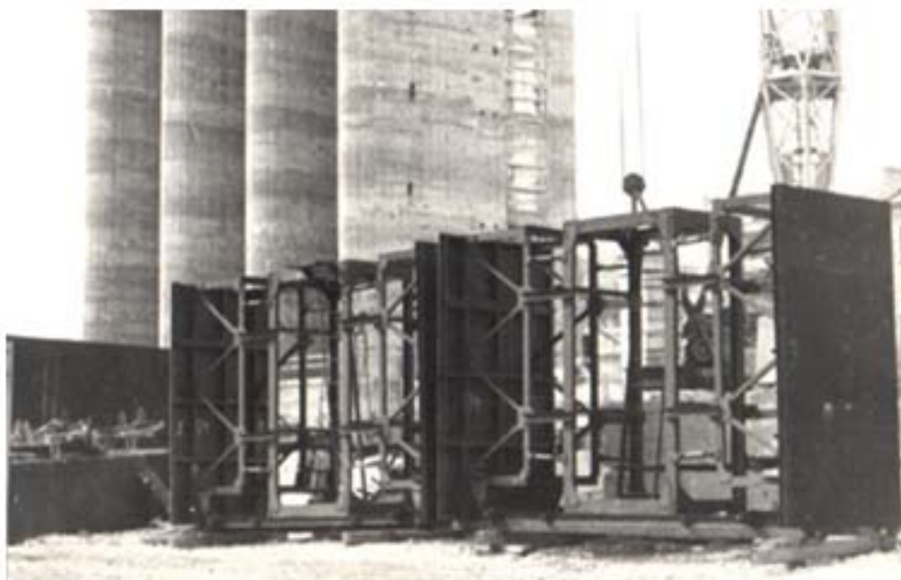
Фото 1. Двухщитовые опалубки для бетонирования коридора
