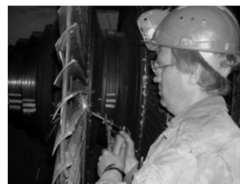
Рис. 3. Формирование эрозионно-стойкого покрытия из металлокерамического твердого сплава ВК60М на входных кромках РЛ 30-й ступени турбины ПТ-80-130 ЛМЗ (ст. № 1) АО «Кишиневская ТЭЦ-2» Республики Молдова.
