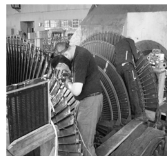
Рис. 4. Формирование защитных покрытий на РЛ 34-й и 39-й ступеней при ремонте турбины К-300-240 ЛМЗ ТЭС «Гацко» (ст. № 1) (Республика Сербская Боснии и Герцеговины) при вскрытой крышке цилиндра. На переднем плане при обработке РЛ 34-й ступени показано использование установки КГБ-5М, на заднем плане – двухкорпусной установки КГБ-5.
