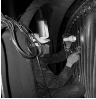
Рис. 5. Формирование защитных покрытий на лопатке 55-й ступени через конденсатор при ремонте турбины К-800-240 ЛМЗ ЗАО «Нижевартовская ГРЭС» (ст. № 1) с использованием установки КГБ-5.
