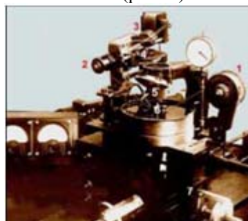
Рис. 6. Первая в мире электроискровая установка с электродом-проволокой \varnothing 20\text{--}40 мкм
