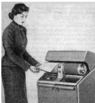
*Рис. 46. Внешний вид электроискровой фотогравировальной установки «Стенофакс»*
