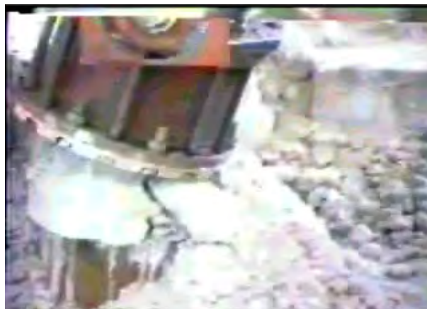
Рис. 2. Щадящее разрушение (в последней фазе) слоя бетона над захороненным тонкостенным контейнером диаметром 450 и высотой 250 мм.
