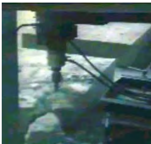
Рис. 4. Разделка на блоки 300X300X300 отделенной ЭРГУК с концентратором от плиты бетона (пластифицированного) 1500X1500X300 полосы 1500X300X300 мм 3 : а – начало процесса отделения; б – отделение блока от полосы.
