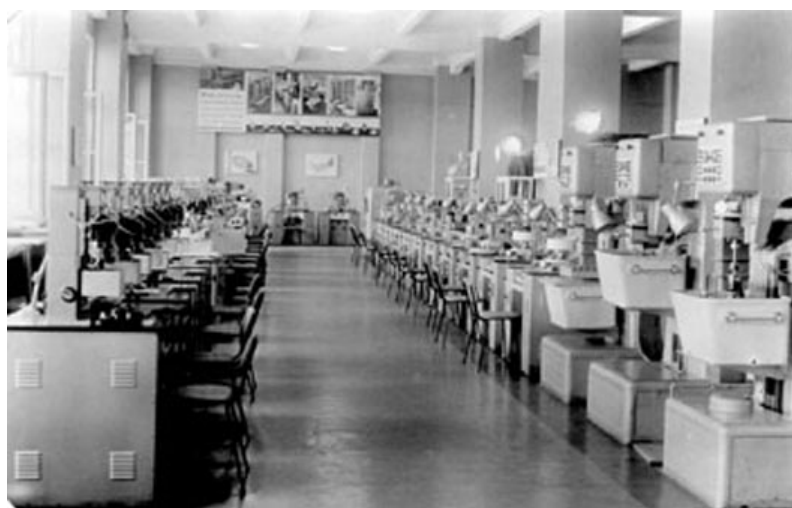
Рис. 3. Общий вид опытно-производственного электроискрового участка отдела электроискровой обработки материалов НИИЭТ МЭП СССР (ныне ГНПП “Исток”).
