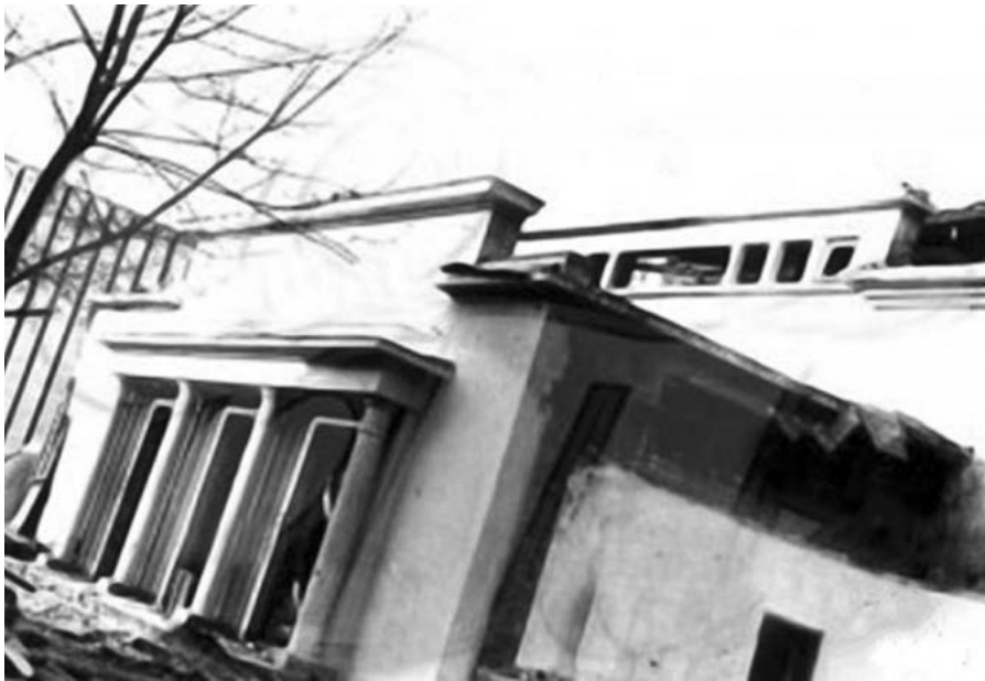
Fig. 9. Începutul demolării clădirii fostului Teatru „Scala”, Bălți, 1977 [16].
