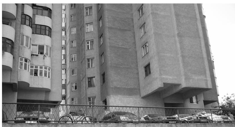
Рис. 1. Монолитное здание с подрезкой стен нижних этажей.
