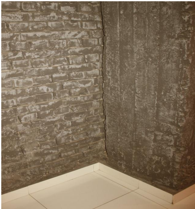
Рисунок 9. Остатки существовавших ранее конструкций стен (кинотеатр «Патрия») - кладка
