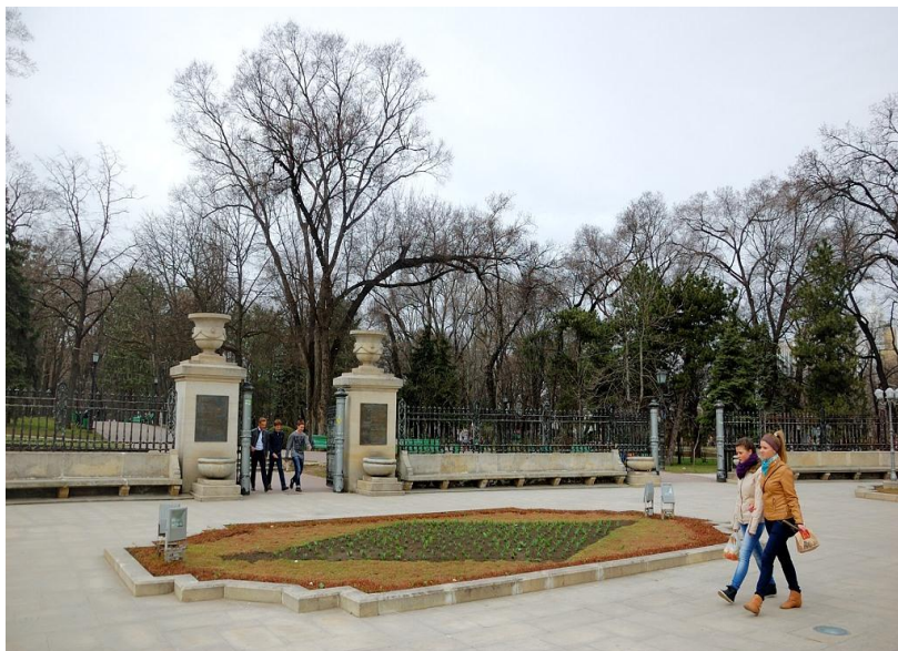
Рисунок 3. Общий вид существующего ограждения
