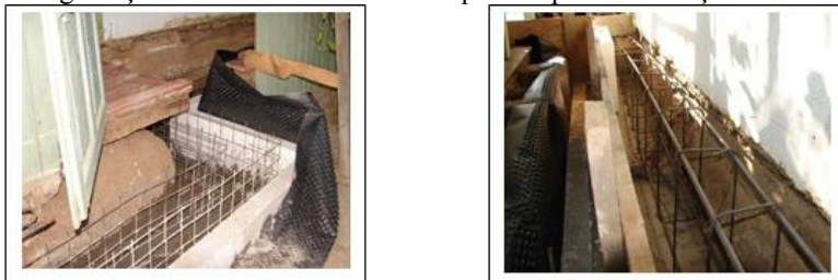
Fig. 5 – Detalii fundații tălpi fundare si pardoseli
