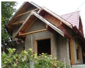
Fig. 2 - Locuința în faza actuală în timpul execuției reabilitării și modernizării
