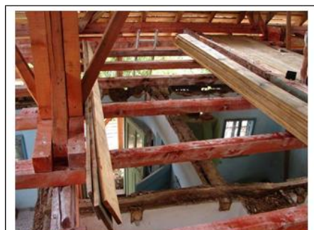
Fig. 7 – Noua structura realizată din grinzi de lemn, ignifugat
