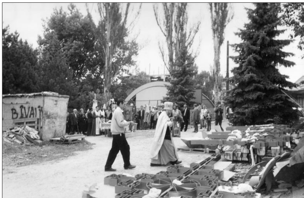
10 octombrie 2006. Sfințirea și instalarea crucilor pe acoperiș.
