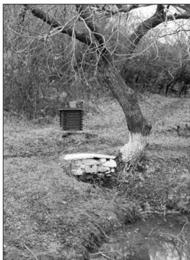
Izvor cu fântână (cu zăcătoare pentru acumularea apei)
