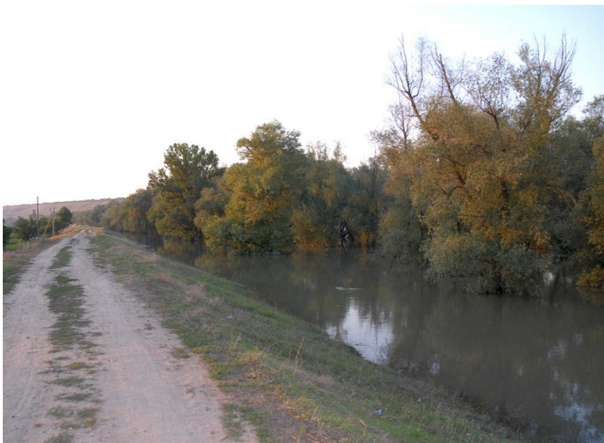
Figura 5. Vedere asupra drumului de îndiguire a luncii din zona de protecție a Nistrului, pentru menținerea undelor de viitură și inundațiilor
