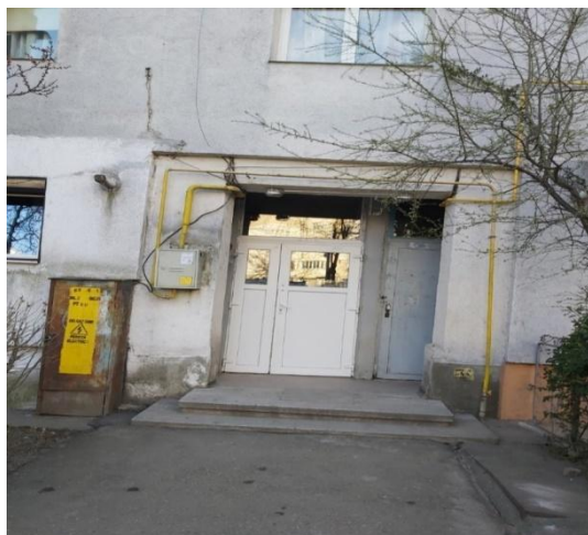
Blocul de pe Aleea Vișinului, nr. 2 din Bacău în care a locuit în ultima parte din viață, scriitoarea
