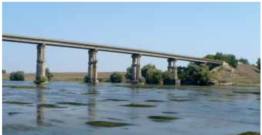
Figura 1. Procesele anormale de împânzire cu vegetație acvatică și colmatare progresivă a albiei fl. Nistru creează medii perfecte pentru expansia și proliferarea speciilor interveniente de pești
