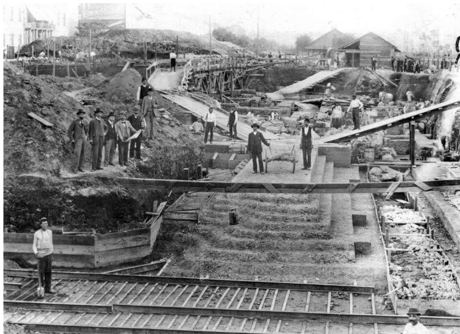
Рис. 1. Роботи з укладання фундаментів майбутнього оперного театру
