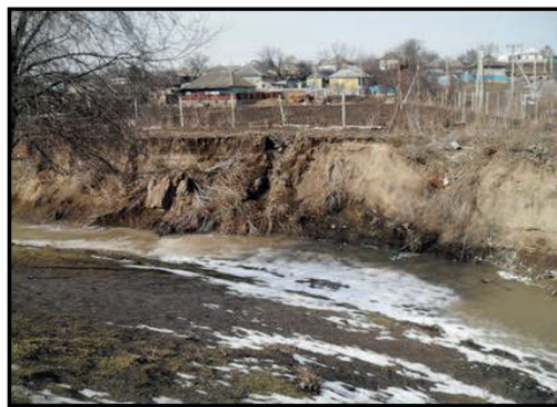
Fig. 111 Malul drept al râului Larga afectat de surpări, Tartaul
