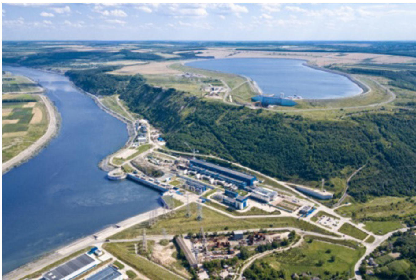
Fig. 1.5. CHEAP cu cel mai mare lac construit pe malul carstic al fl. Nistru în apropiere de or. Ocnîța; lacul se alimentează din fl. Nistru ( https://uges.com.ua/ru/content/dnistrovskaya-gaes )
