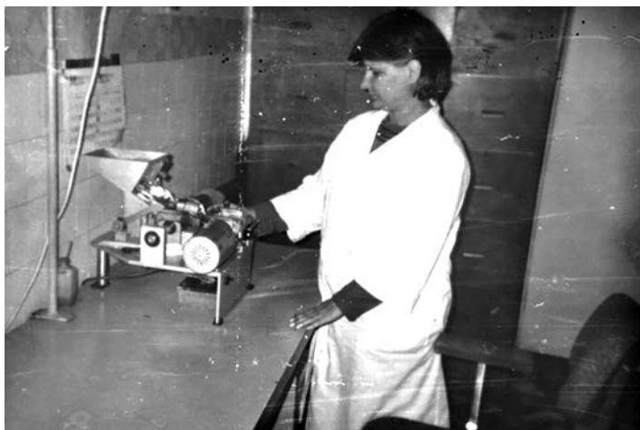
Foto 6. Mașină semiautomată pentru imprimarea paietelor
