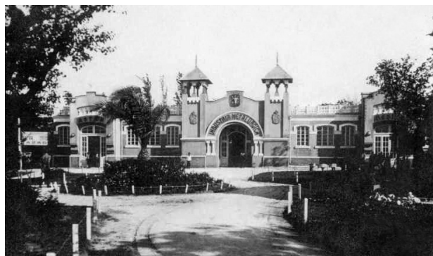
Pavilionul industriei metalurgice
