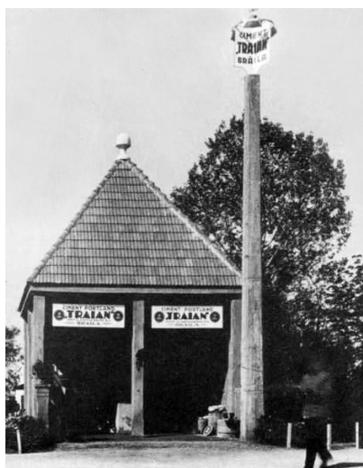
Pavilionul Fabricii de Ciment „Traian”
