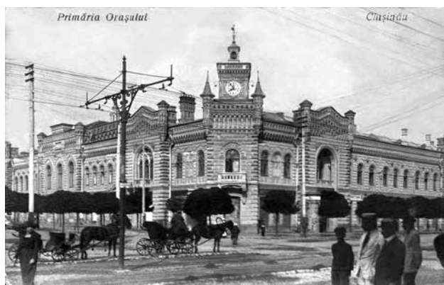
Foto 14. Clădirea Primăriei orașului Chișinău (reședința județului Lăpușna) în perioada interbelică. Foto din sursa: http://romaniain-terbelica.memoria.ro/judete/lapusna/
