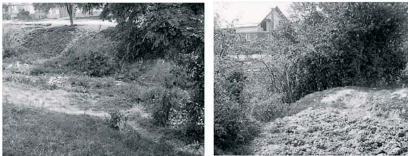
Fig. 3. Taluzuri erodate de apele pluviale
