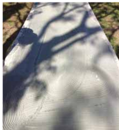
Figura nr. 2 - Fixare izolație pe placa de rigips.
