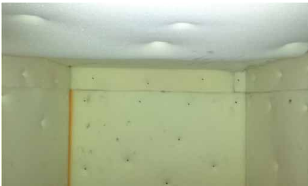
Figura nr. 7 - Placarea pereților interiori cu burete poliuretanic.
